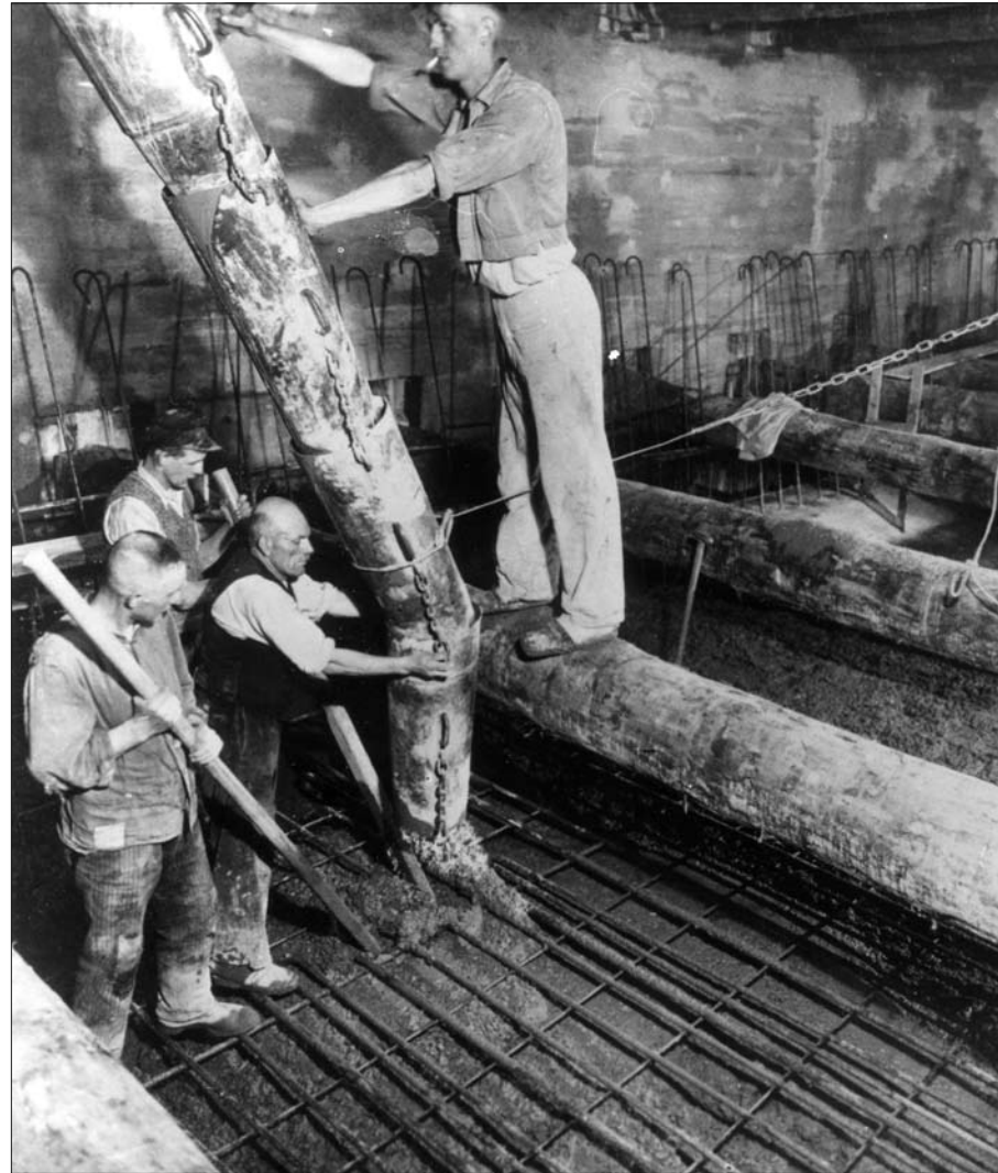
↑ Das Bild zeigt Arbeiter bei der an der Nordsüd-S-Bahn meistausgeübten Tätigkeit, dem Betonieren, hier der Tunnelsohle. In der Regel wurde der Beton in Anlagen unter dem Straßenland gemischt. Foto: Hist. Slg. DB AG (1935)
