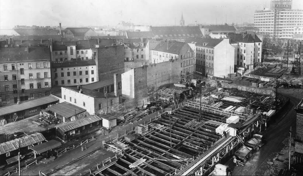
←↑ Baugrube auf der nordwestlichen Seite des Anhalter Bahnhofs. Teile des Empfangsgebäudes, u. a. das denkmalgeschützte Fürstenportal, wurden abgebrochen und nachfolgend wieder aufgebaut. Die Zeichnungen zeigen die Unterfahrung im Detail. Foto: Max Krajewsky/Slg. SBM (11.12.1936). Zeichnungen aus: ZdBV 4-5/1940
