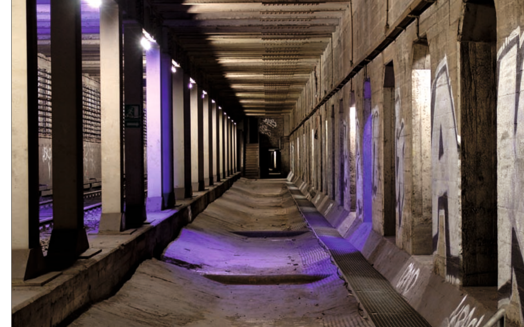
↑ Zwischen Anhalter Bahnhof und Potsdamer Platz: der immer leere Gleistrog, der einmal ein Kehrgleis aufnehmen sollte. Zwischen der darüber erkennbaren Betondecke und der Straßenebene befindet sich ein Luftschutzbunker, der sogenannte Hängebunker. Im Hintergrund führt eine Treppe aus dem Tunnel dorthin, weitere Zugänge existieren von der Straße aus. Foto: Markus Jurziczek
